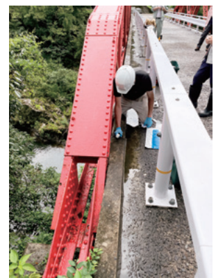
橋梁への「ポリマエース®」施工の様子
