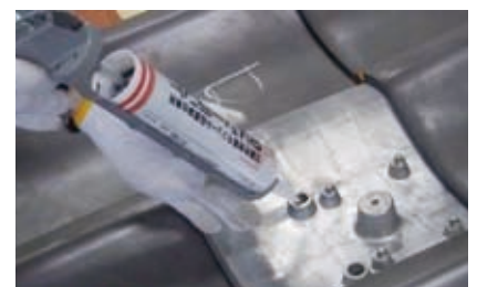
PVシーラントを使って施工中
