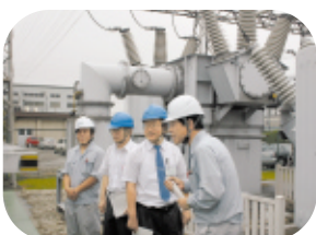
東京工場東側にある特別高圧変電所を視察
