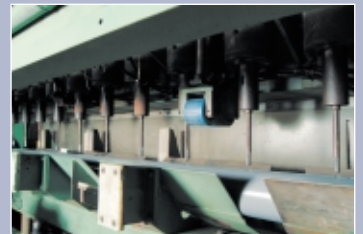
有孔管のドリル穿孔 この穿孔屑（C品）も回収
