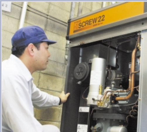
▲コンプレッサーCP2のインバーター化
