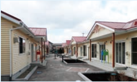
八戸市新井田道災害公営住宅本棟で7棟41世帯分に『ポリマパネル』が採用
