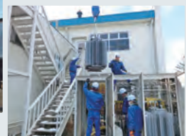
しなのポリマー(株) 高圧トランス撤去
