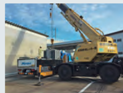
新潟ポリマー(株) 高圧トランス搬出
