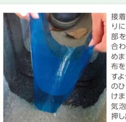
接着面側を外側にし2つ折りにして両端を持ち中央部をU字溝の底の中心に合わせてから貼り付け始めます。無理に引っ張らず布を敷くような感じで垂らすように置いて中央より手のひらで押し広げて貼り付けます。目視確認しながら気泡が残らないよう外に押し出します。
