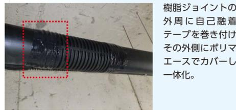
樹脂ジョイントの外周に自己融着テープを巻き付けその外側にポリマエースでカバーし一体化。
