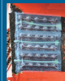
P-VAC工法 複数のボルトナットを一度に施工可能
