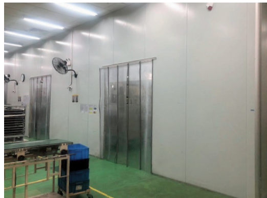
設備を仕切りで囲い、 出入口は防炎ビニールカーテンを設置
