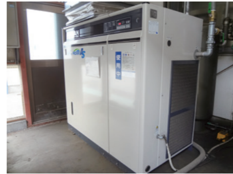
省エネタイプのインバーター式コンプレッサー (トップランナーモーター使用)
