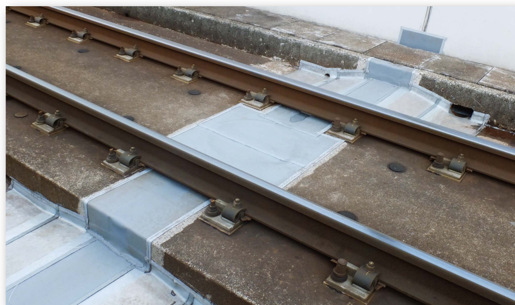
遊間部の底面への施工も短時間で可能
