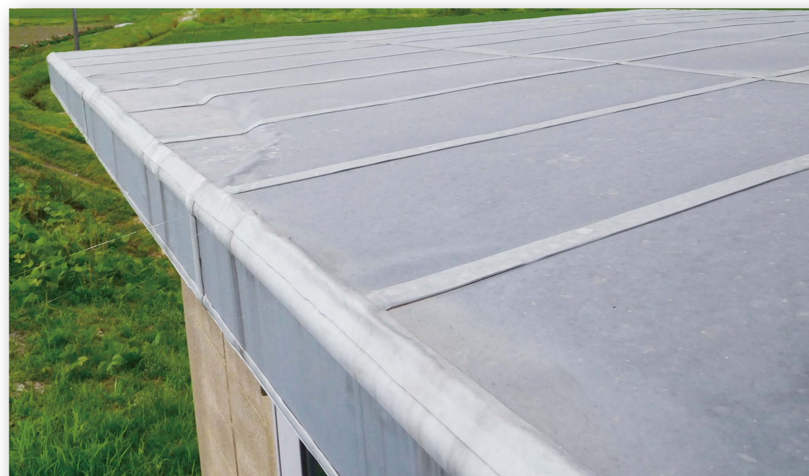
シートを連続貼りし、接続部をポリマエースPAで一体化
