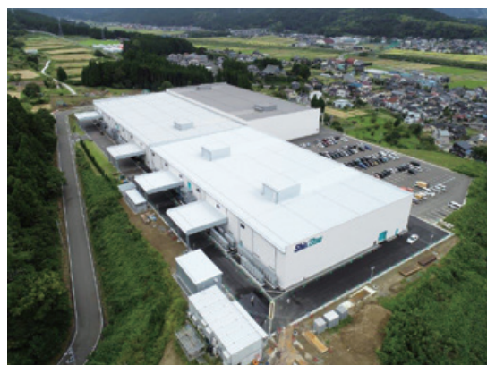
手前が拡張した生産棟
