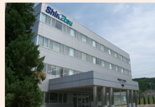
生産能力増強を進める糸魚川工場
