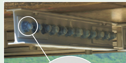
実際の 橋梁施工例
