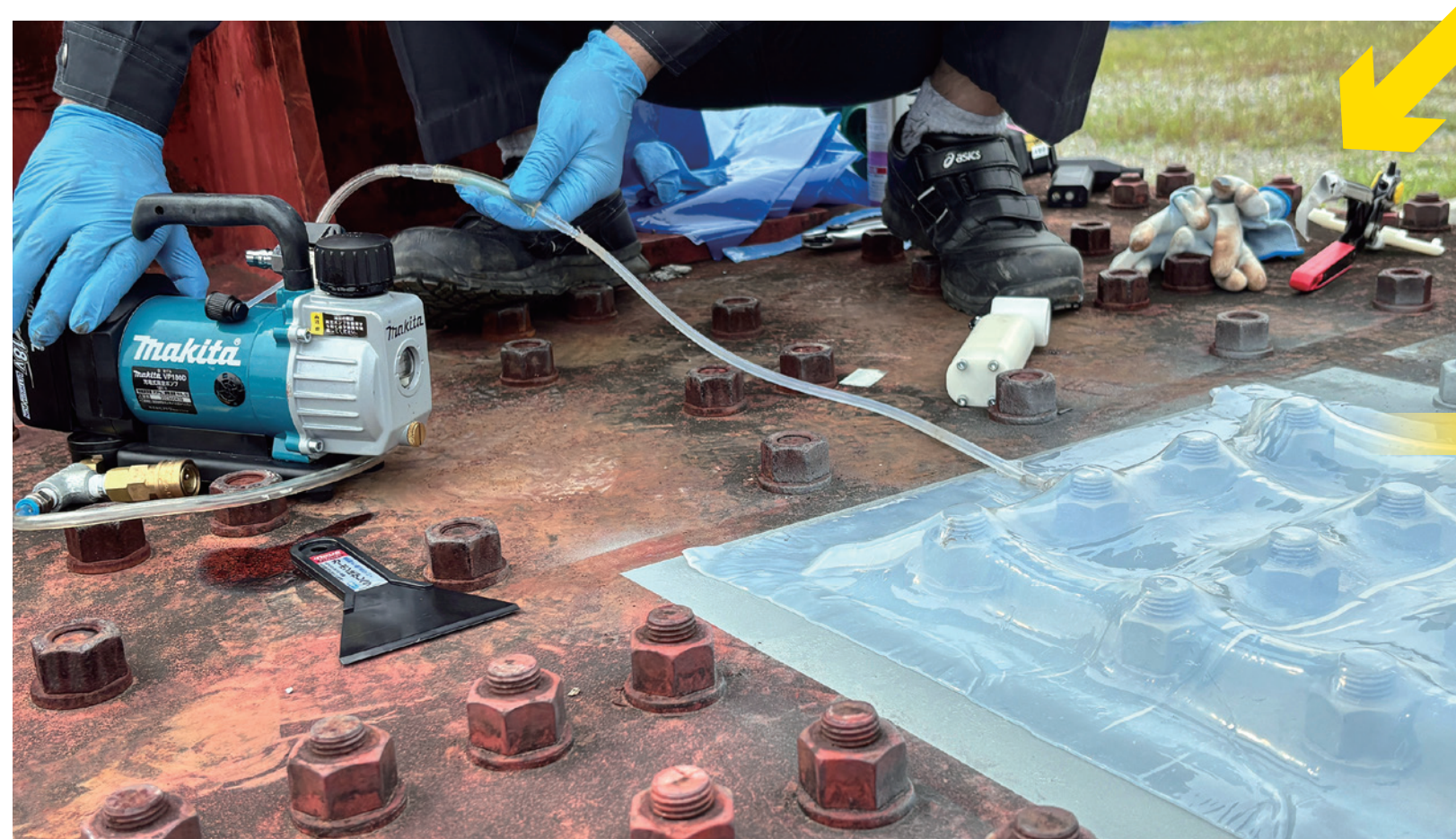
⑤ 真空ポンプに吸引チューブを接続する
