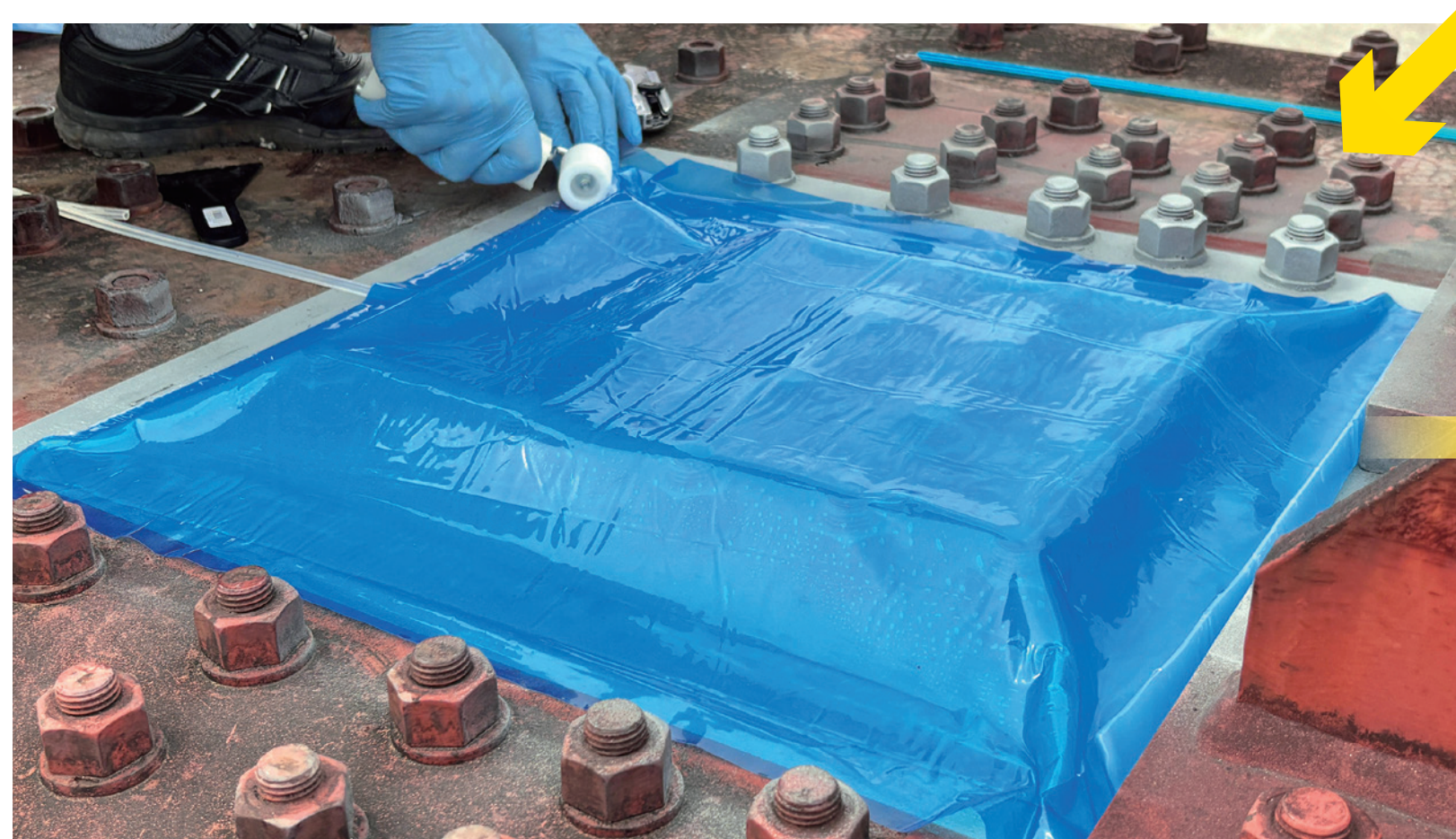
③ 4 辺の端部をローラーで封止する
