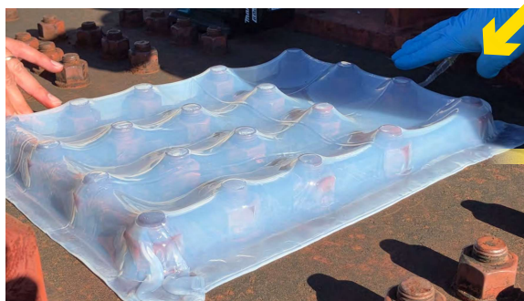
⑤ チューブに真空ポンプを接続する
