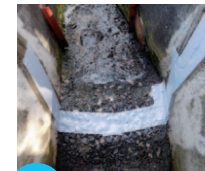
止水 Water stop U字溝クラック補修 U-shaped gutter crack repair
