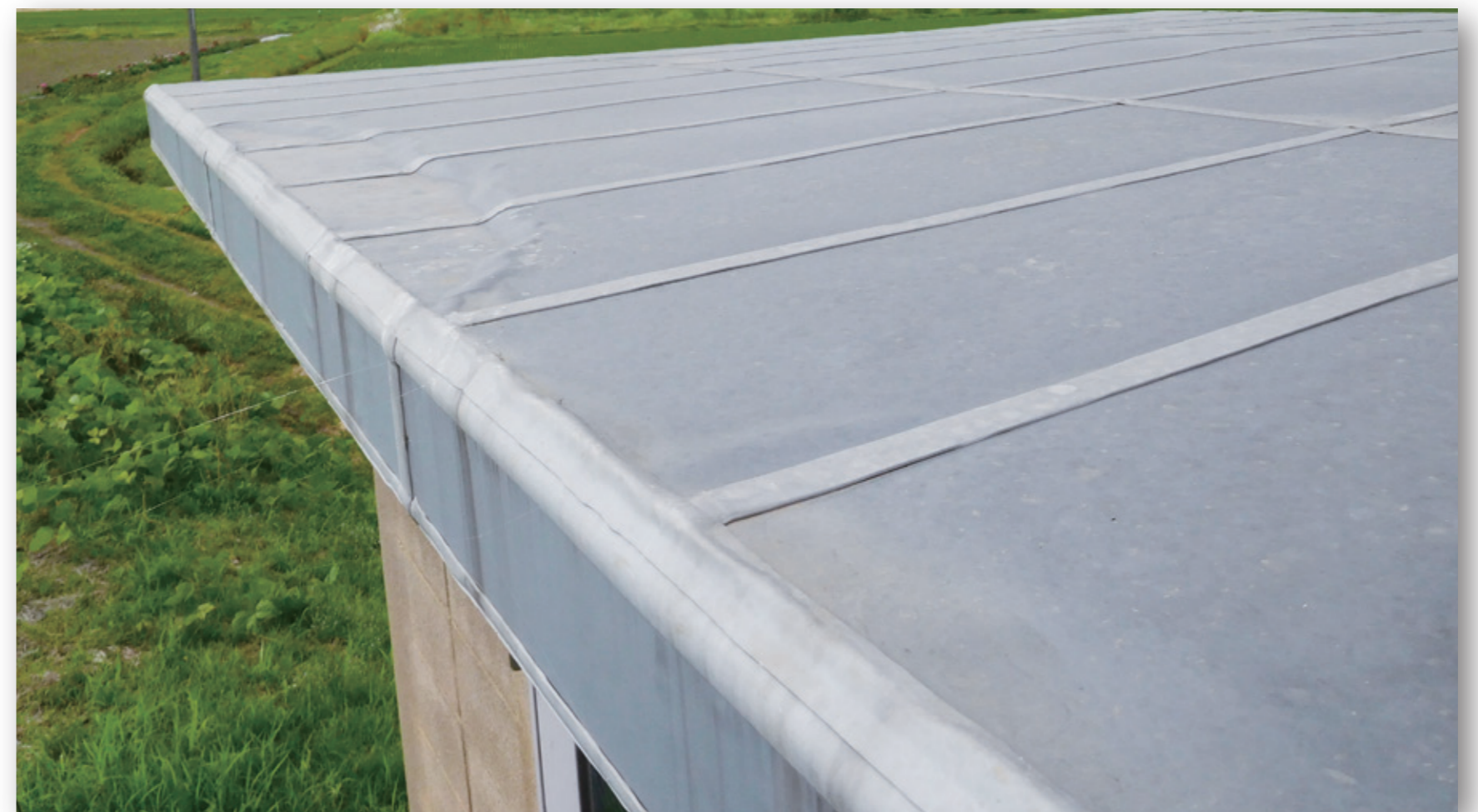
シートを連続貼りし、接続部をポリマエースPAで一体化
