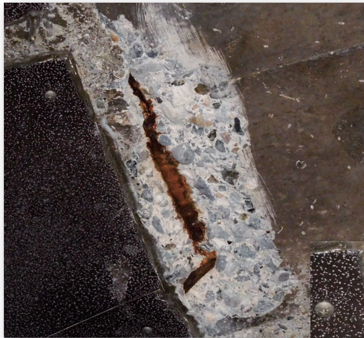
施工前 鉄筋がむき出し
