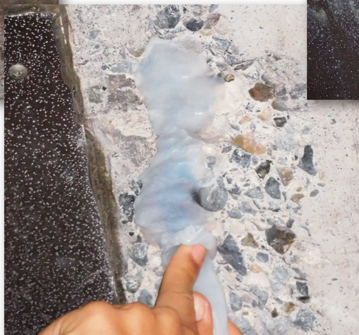
ポリマエース施工中
