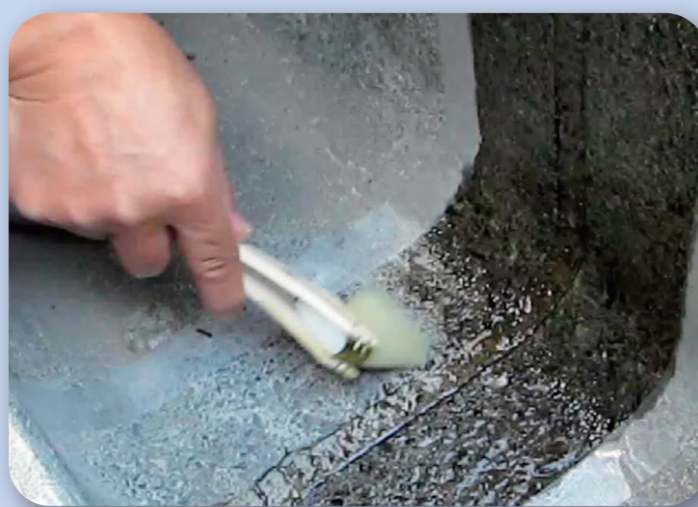
プライマー塗工
