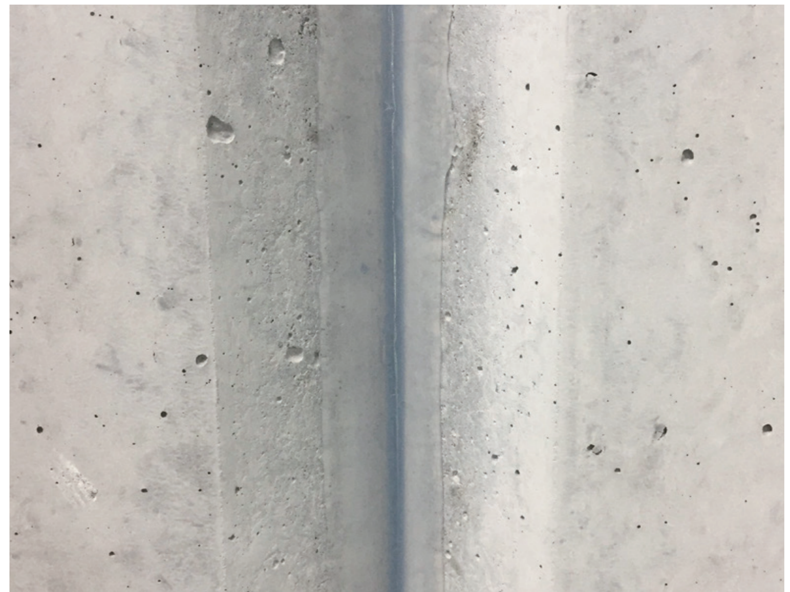
絶縁目地の漏水補修が外部から可能
