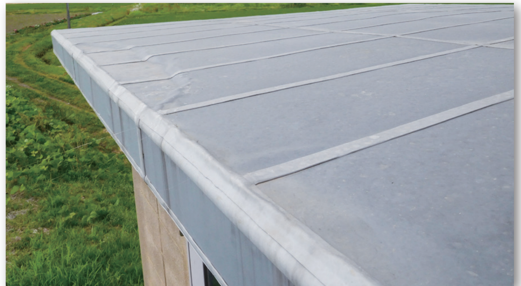
シートを連続貼りし、接続部をポリマエースPAで一体化
