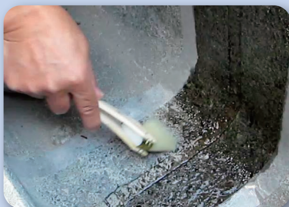
プライマー塗工
