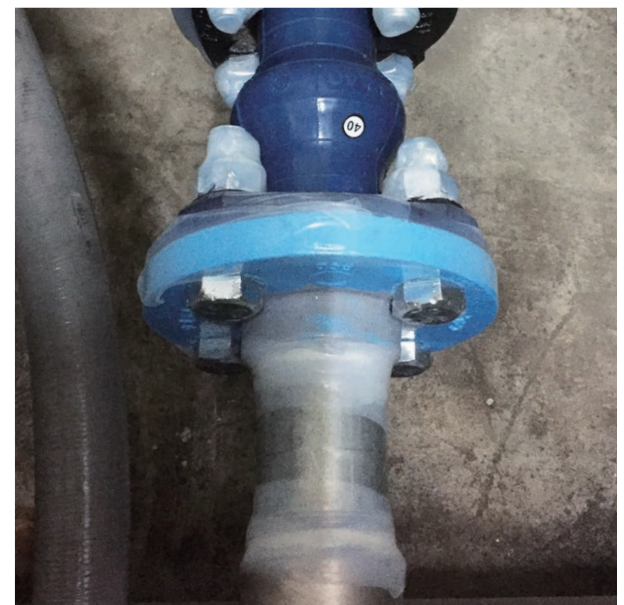
フランジやボルトに巻き付けるだけで、さび止めが可能
