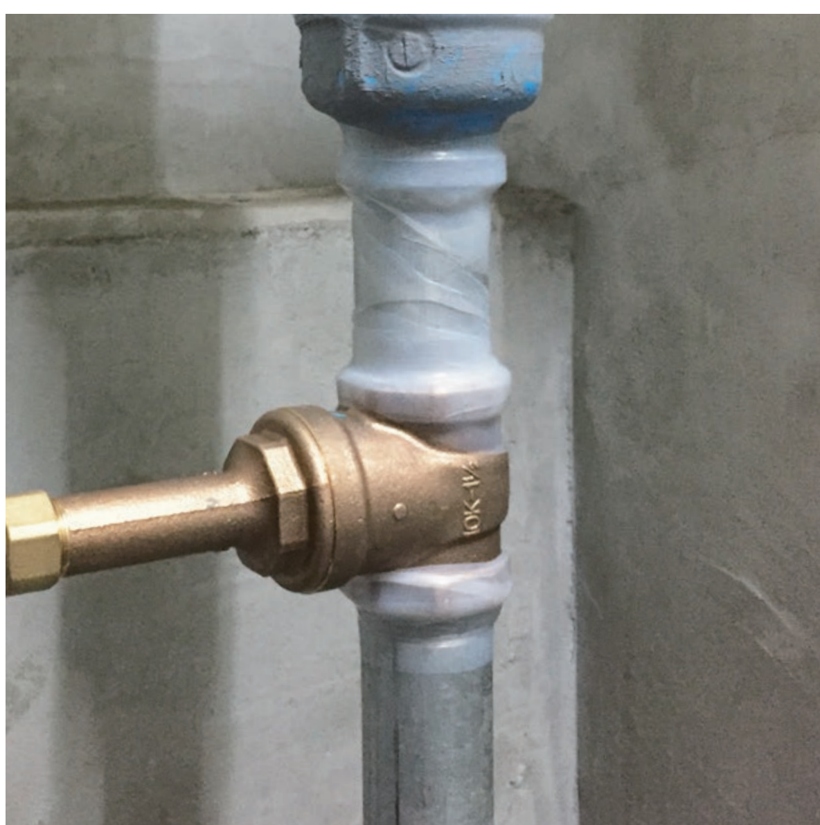
配管ジョイントからの水漏れや、さび防止が可能
