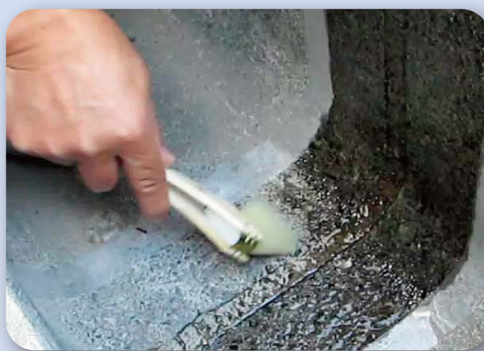
プライマー塗工
