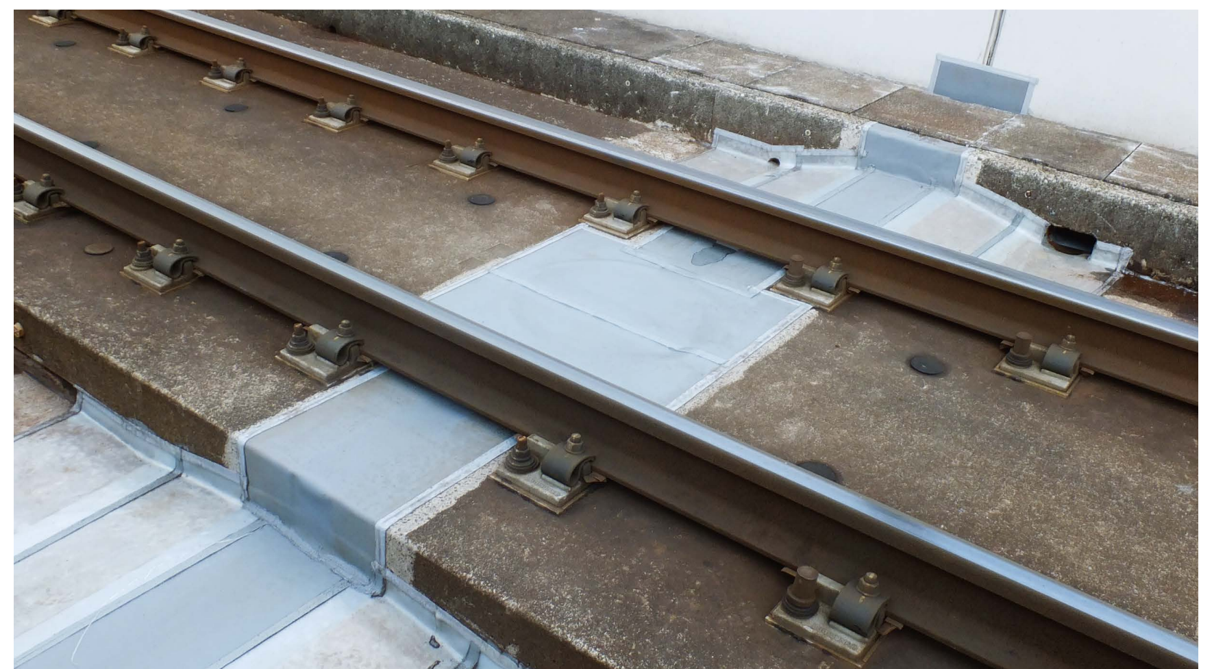
遊間部の底面への施工も短時間で可能
