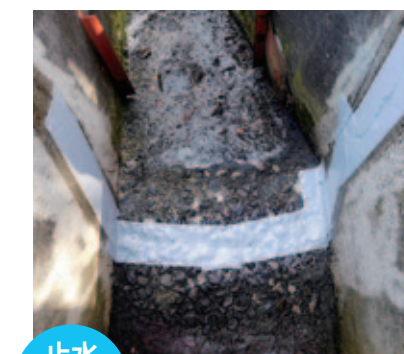
止水 Water stop U字溝クラック補修 U-shaped gutter crack repair
