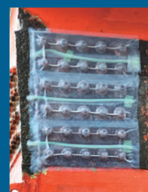
P-VAC工法 複数のボルトナットを一度に施工可能
