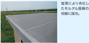
補修箇所のクレン、プライマー塗布、ポリマエースUG貼付け、2日間養生して完了
