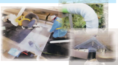
新幹線高架橋の絶縁目地を外側よりポリマエースUGを貼って施工し水の漏れを補修しました。 下地調整から施工完了まで30分程度
