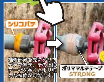
粘土のような粘着で、練り込んだり貼り付けることで補修箇所にピタッと密着します。硬化しないので、いつでも簡単にきれいに剥がすことが可能な
